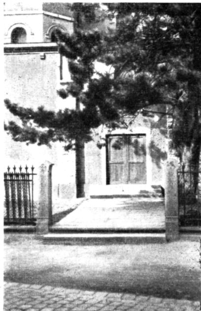
Porte latérale provisoire
