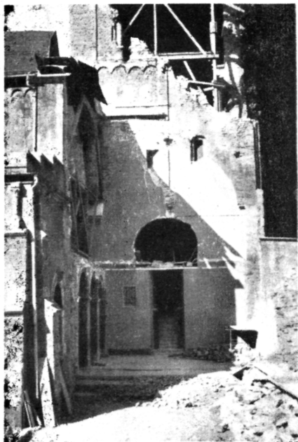
Après la démolition du narthex
