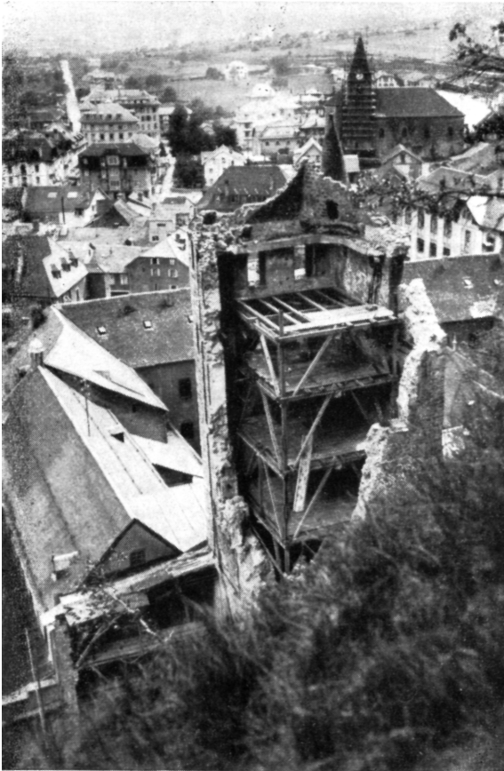
La tour éventrée et les premiers échafaudages
