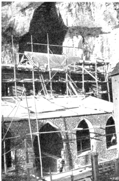
Fig. 17. Construction des dalles de couverture et de protection sur la nef (en cours d'exécution) et sur les bas-côtés (terminées).
