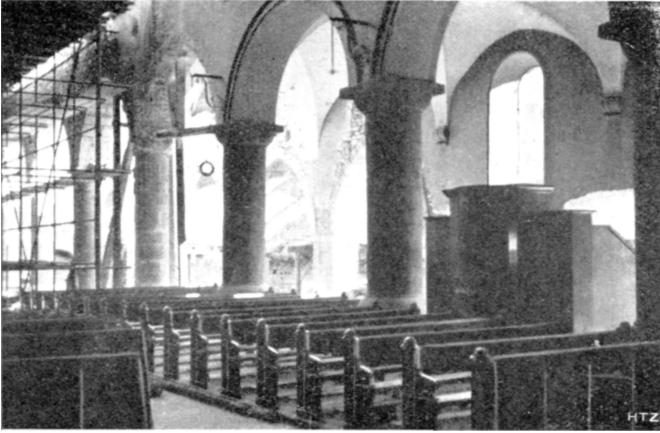
Fig. 14. Vue intérieure prise de la nef et montrant le bas-côté et les chapelles.
