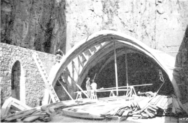
Fig. 15. Coffrage des voûtes de la nef. Hauteur à la clef 13 m.
