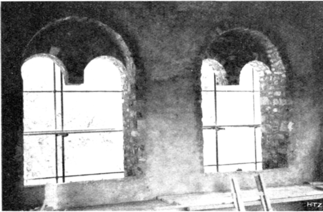
Fig. 7. Fenêtres géminées des étages supérieurs.
