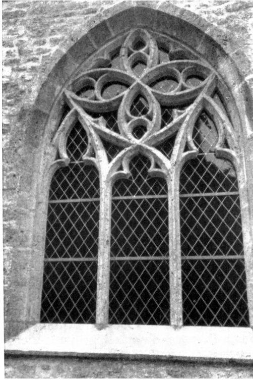
Fenêtre en tuf de la chapelle des Abbés
