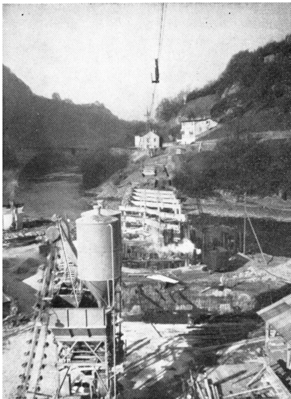
Les chantiers du futur pont durant la première phase des travaux.
