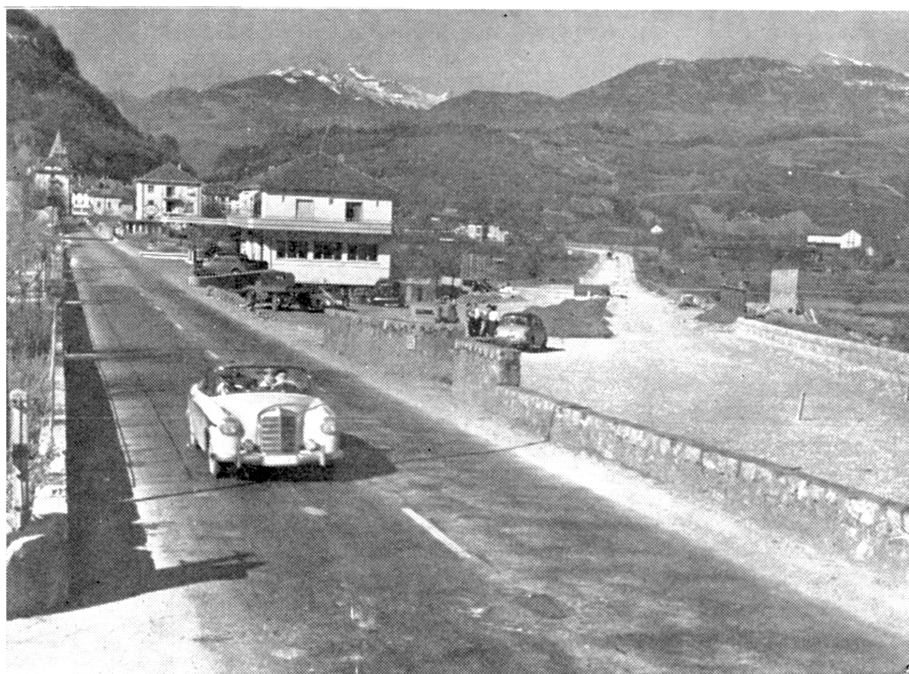
Bifurcation en amont de Saint-Maurice : à gauche, la route cantonale venant de la ville ; à droite, la nouvelle route passant entre la ville et le Rhône.
