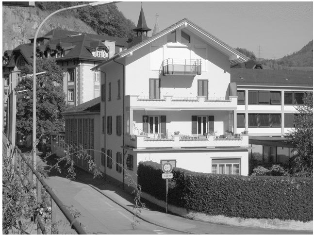
La maison dite Vuilloud, Dubois ou Morend, à la rue Saint-Sigismond, au terme des travaux de restauration qui viennent de s'achever.
