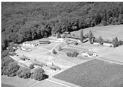
Vue aérienne du Camp de Vaumarcus.
