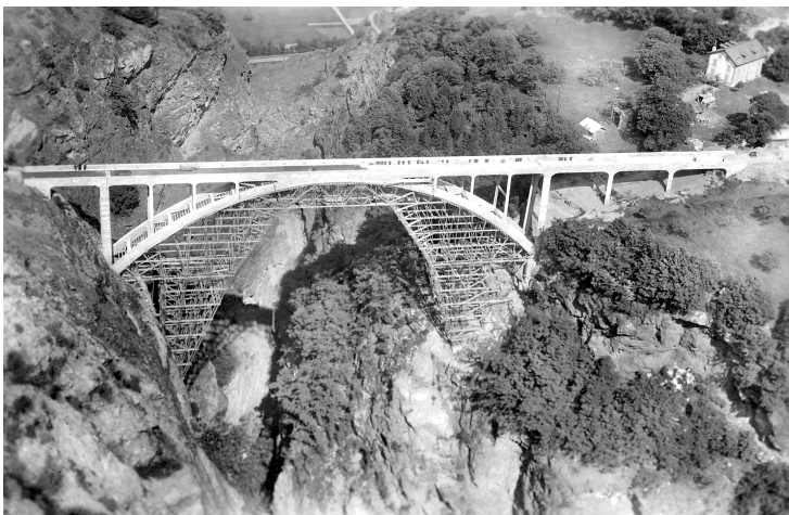
Le fameux pont du Gueuroz a été construit en 1934 sur une armature en bois. Cet impressionnant cintre fut monté par l'entreprise de charpente Richard Coray, des Grisons.
